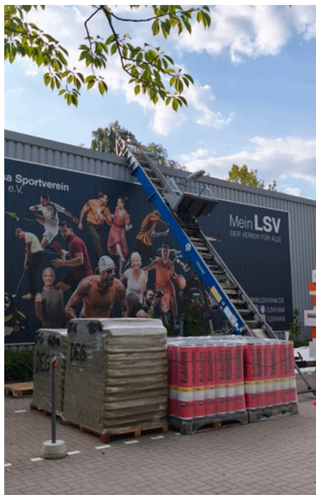
Die Dacharbeiten sollen im Laufe des Jahres abgeschlossen werden. Bild: A. Happach
